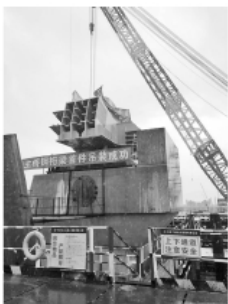
道庆洲大桥跨江主桥钢桁梁昨完成首件吊装。
